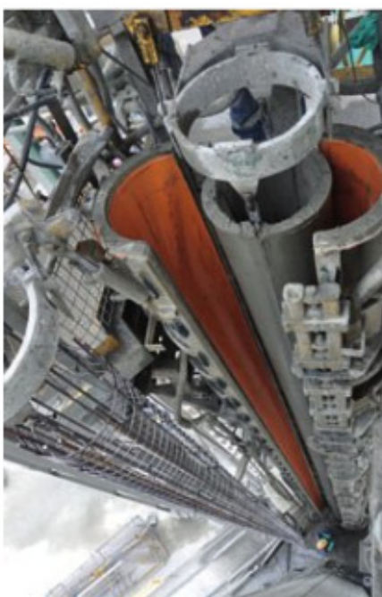
Figuras 2, 3 y 4: Proceso de desencofrado de los postes recientemente hormigonados.
