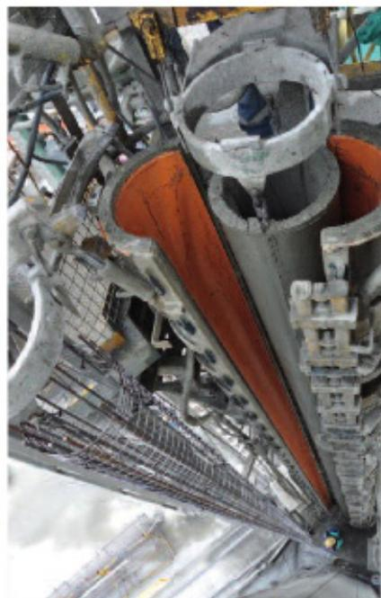
Рис. 2, 3 и 4: Распалубка свежесобетонированных столбов
