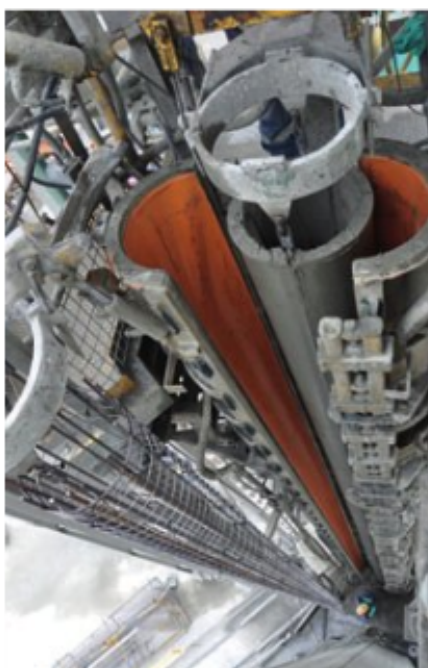
Abb. 2, 3 und 4: Entschalungsprozess von frisch betonierten Masten.
